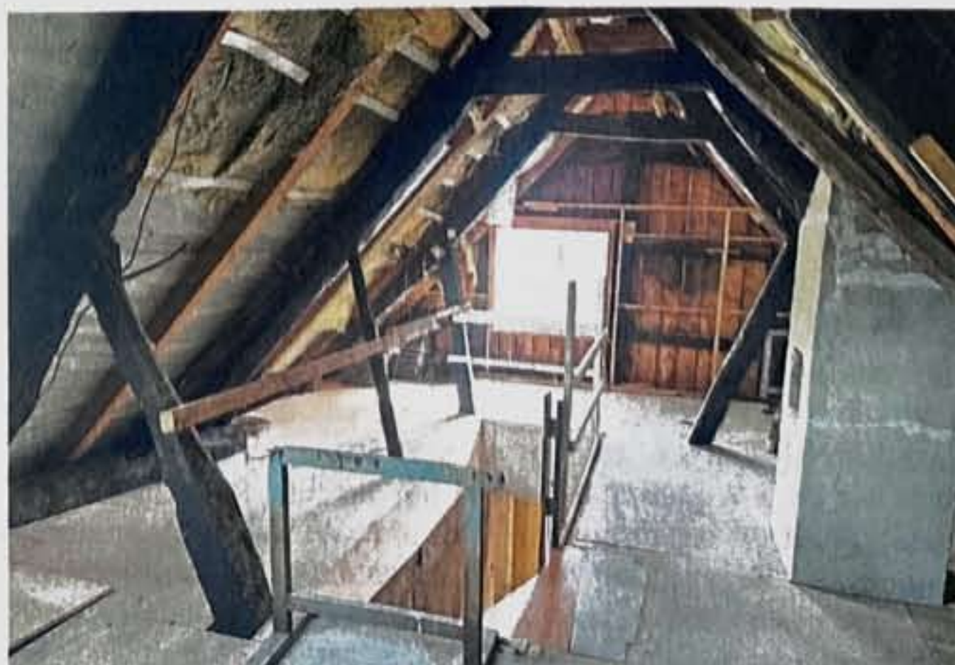
Der Dachboden wird ausgebaut und bekommt auf der Westseite (im Rücken des Bildes) eine Außenloggia.
