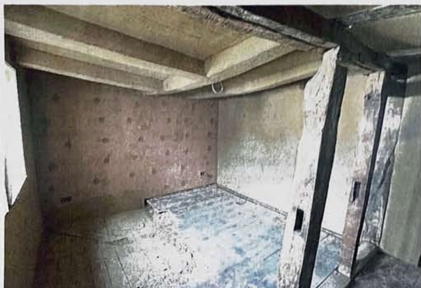
Hier ist die Holzfaserdämmung an der Wand zu erkennen und der Lehmputz unter der Decke.
